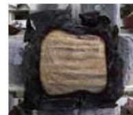
燃焼後の太い柱
